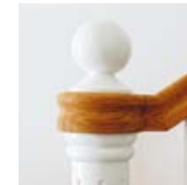
27 DETAIL Pfosten kanneliert, Handlauf-Schnecke, Eiche / weiß lackiert
