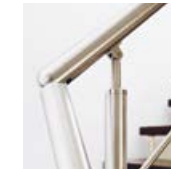
31 DETAIL Freitragende Bolzentreppe, Eckverbindung Edelstahl- handlauf
