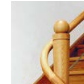
31 DETAIL Freitragende Bolzentreppe, Eckverbindung Edelstahl- handlauf
