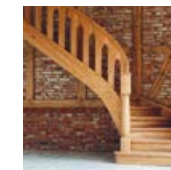
32 WANGENTREPPE Geschlossen, eingestemmt, Gotikgeländer, Eiche
